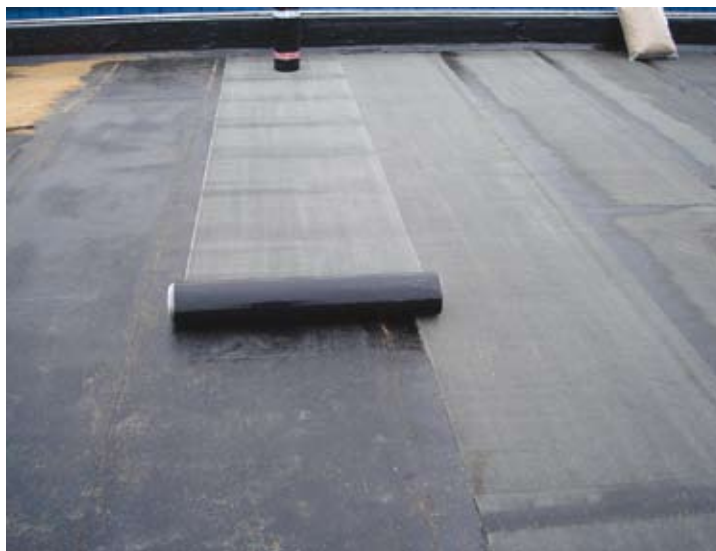
Mehrlagige Dachabdichtung mit Dampfdruckausgleichsschicht. Fotos: Wolfgang Hubner
