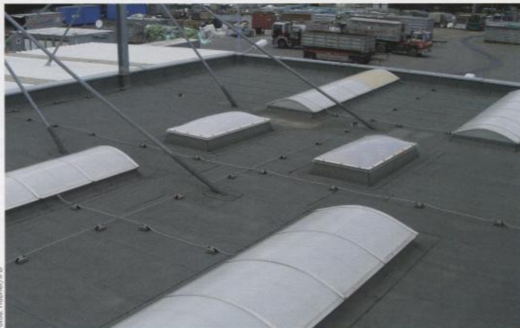
Flachdächer sind schon allein aufgrund ihrer vergleichsweise geringen Kosten attraktiv und damit weitverbreitet.
